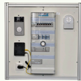
distribution électrique et portier vidéo
